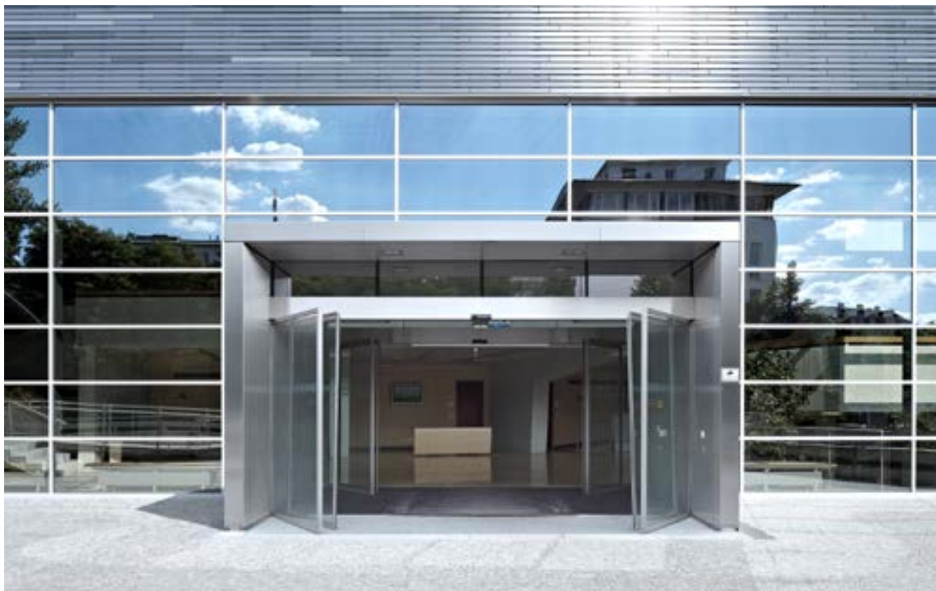
Automatischer Schiebetürantrieb Slimdrive SL-BO, Hörsaalzentrum Klinikum rechts der Isar, München, Deutschland (Foto: Robert Sprang)
