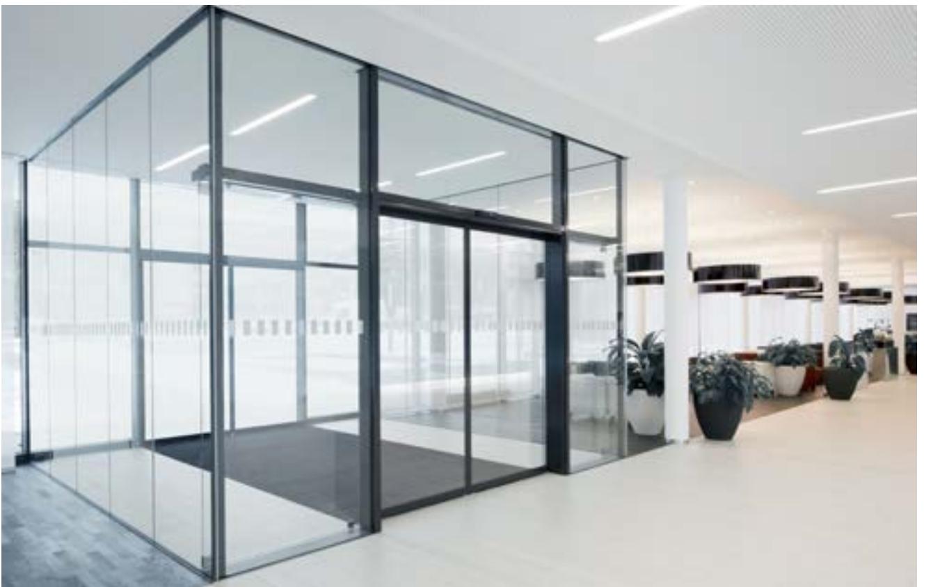
Slimdrive SL NT mit Windfang, Augustinum, Stuttgart, Deutschland (Foto: Dirk Wilhelmy)
