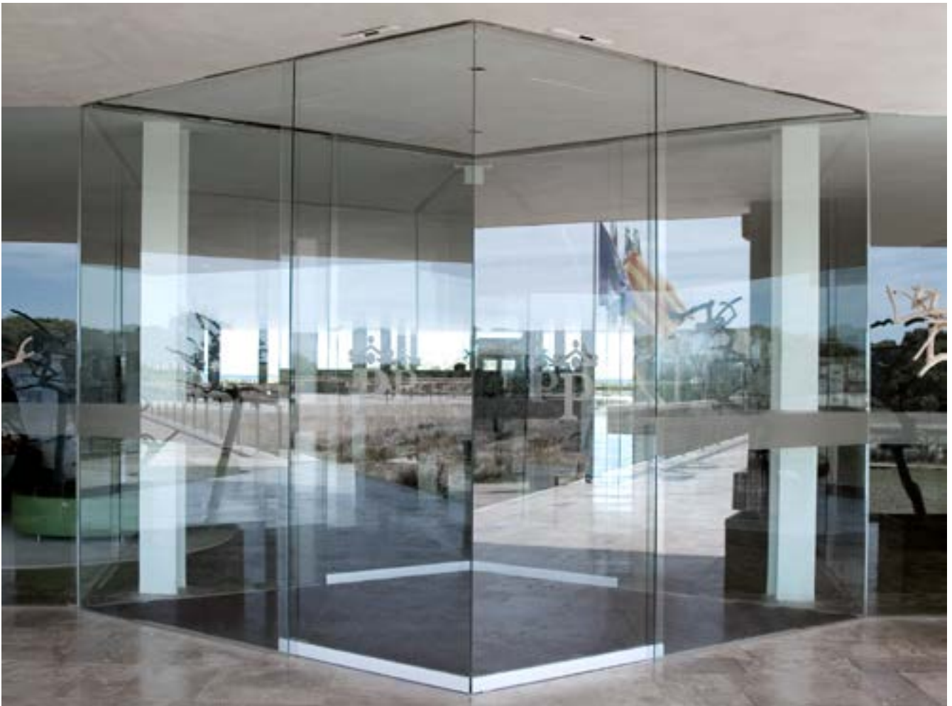
Automatischer Schiebetürantrieb Slimdrive SLV (Winkelschiebetür), Hotel Parador National del Saler, Valencia (Foto: Pau Esculies / GEZE GmbH)
